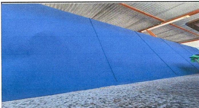
Foto 3: REPARACION DE MUROS: Reparación de muro de tabla yeso, incluyendo refuerzo
