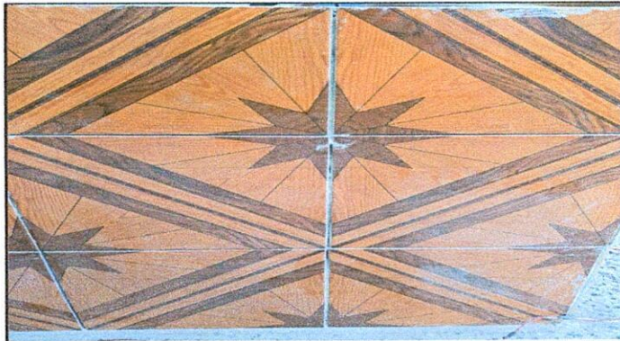
Foto 4: SUSTITUCION DE AZULEJO: sustitucion de piso tipo azulejo, trabajo de nivelación, instalación alineada y sizado en juntas. En meson de cocina
