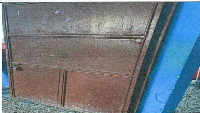
Foto 1: PUERTAS: mantenimiento a puerta metálica existente retiro de óxido, suciedad y pintura deteriorada; incluye cepillado, lijado y aplicación de pintura
