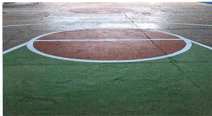
Foto 3: PINTURA EN EXTERIOR Preparacion de la superficie y aplicacion de pintura a dos manos, en lineas de cnache y en porteria
